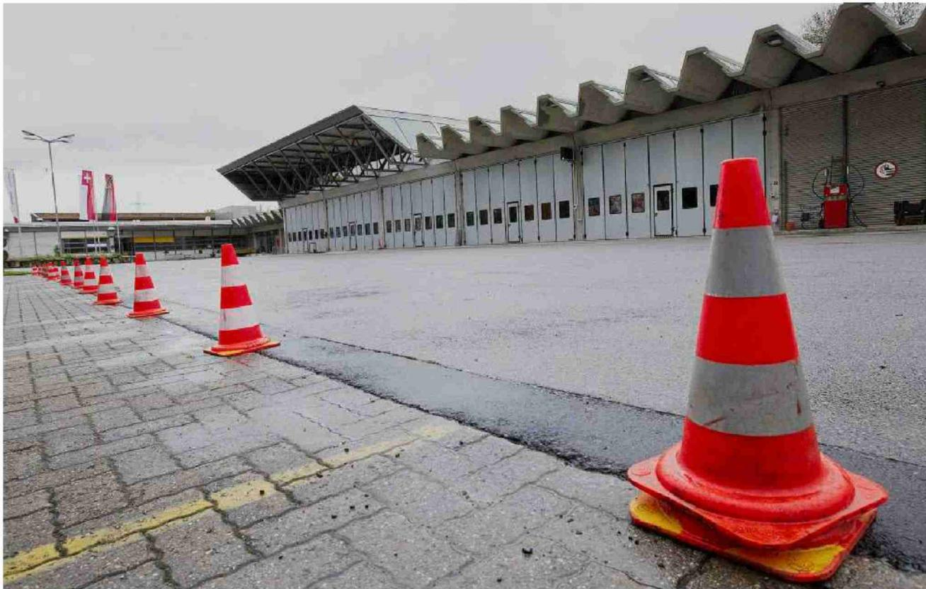
Wie die Zähne einer Säge ragen die pultdachartigen Aufbauten des Daches in die Höhe. Der erhöhte Teil fügt sich in dieses Ganze ein.
