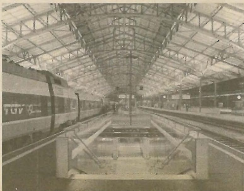
Halle des quais, gare de Lausanne.
